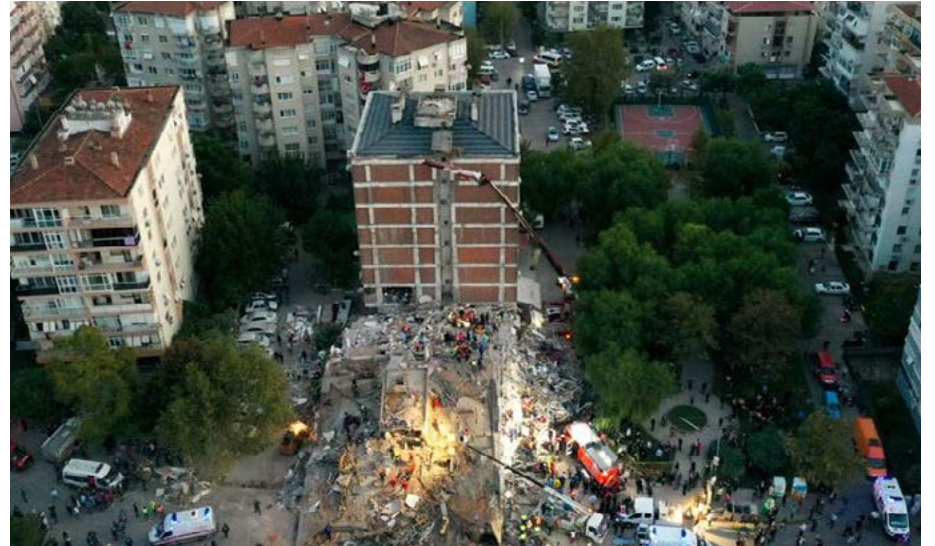
Bayraklı'da deprem sonrasında yıkılan binalardan biri
